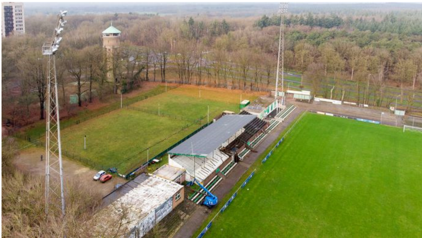
Het nieuwe dak van de hoofdtribune van de Wageningse Berg. © Herman Stöver
